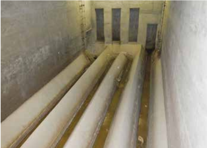
Das Regenrückhaltebecken Oberseen filtert das Mischwasser auch dann, wenn das Becken wegen anhaltender Niederschläge überläuft.
