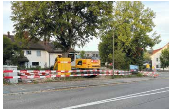
Unter dieser Baustelle beim Grüntal liegt das Regenrückhaltebecken Oberseen mit 140'000 Liter Fassungsvermögen. Es verhindert, dass der Mattenbach mit Abfall und Unrat verschmutzt wird.
