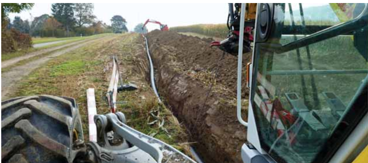
Dänikon, Verlegen der Wasserleitung entlang der Otelfingerstrasse. 29. Oktober 2021.
