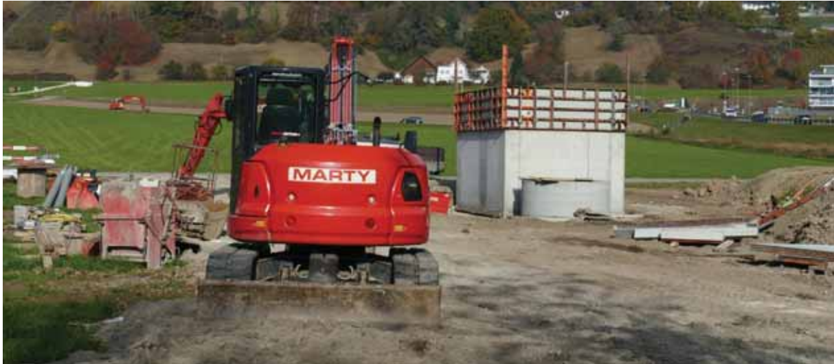
Oetwil a. d. Limmat, die Pumpstation im Bau. 29. Oktober 2021.
