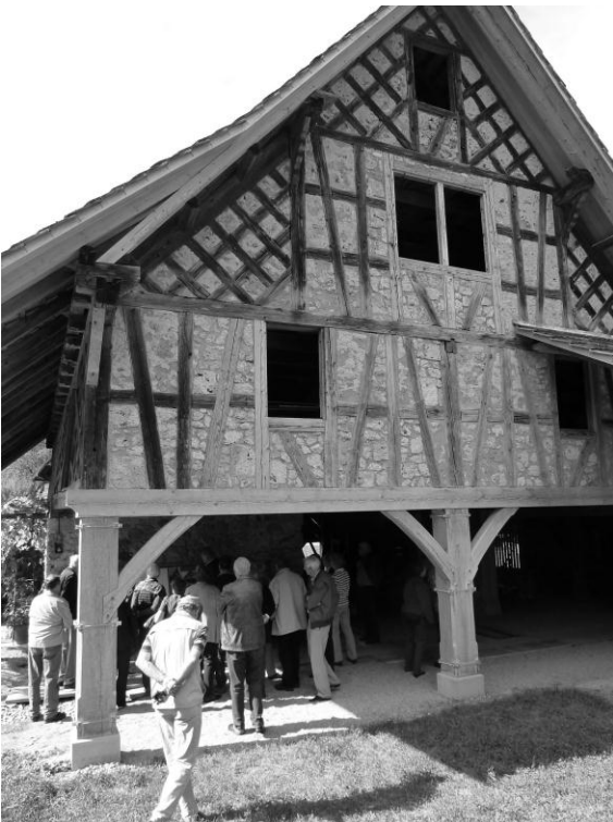
Das grosse Gebäude mit den neuen Eichenpfosten.
