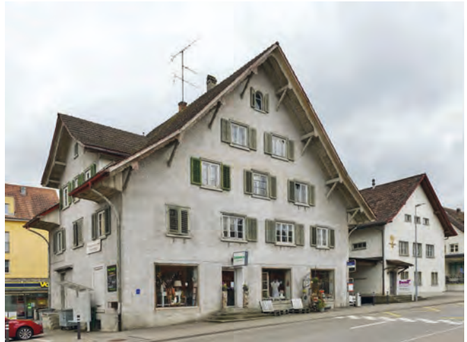
Illnau, Landihaus, Usterstrasse 23, Bild: ZVH
