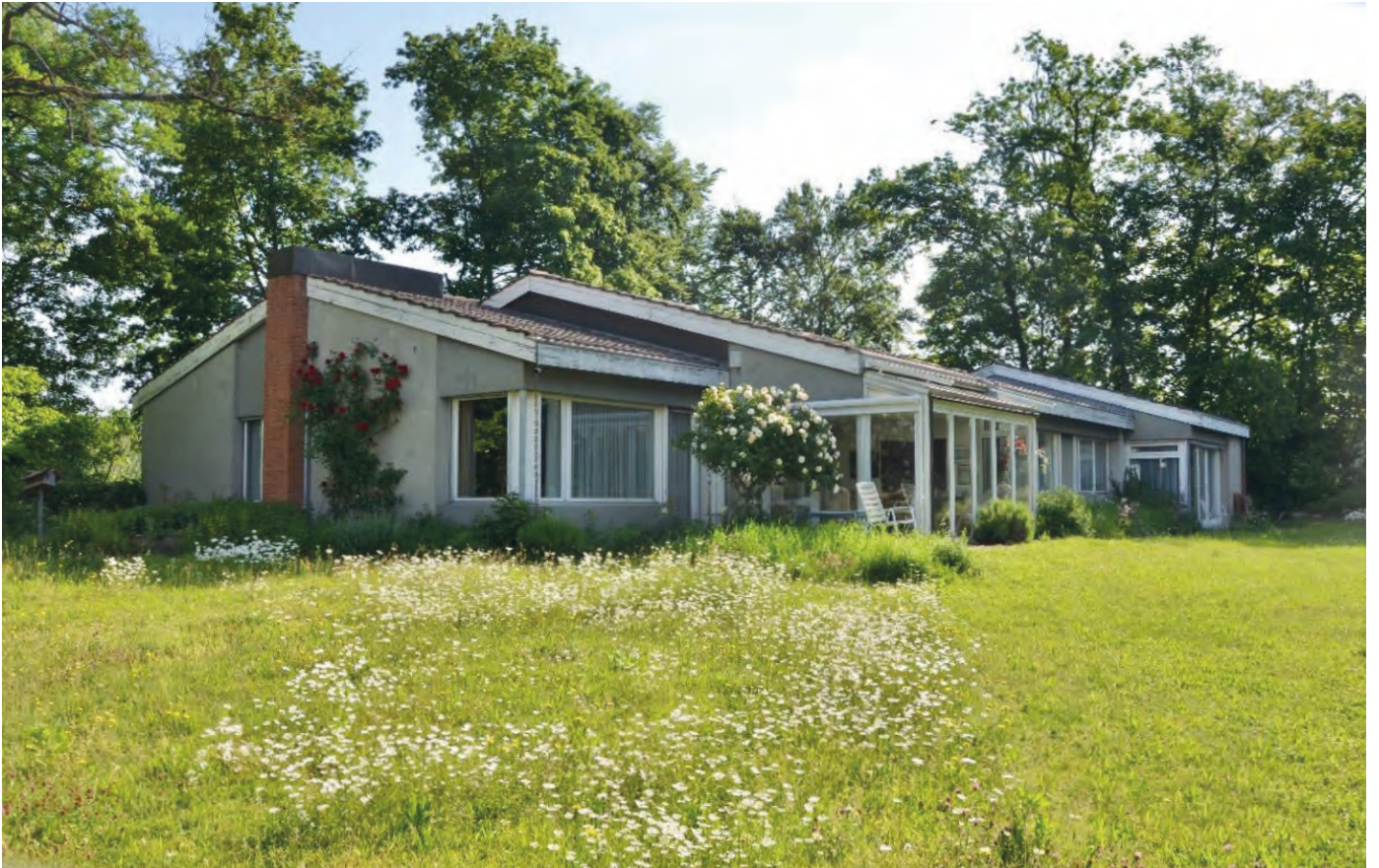
Feuerthalen, Scheibenäckerstrasse 5, 2020. Bild: IBID, Gutachten zur Schutzwürdigkeit
