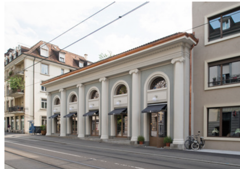
Das ehemalige Kino Razzia an der Seefeldstrasse (Bild: HAL_002027, Juliet Haller)
