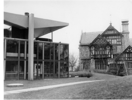
Neu und alt: Corbusier Pavillon und Villa Egli (Bild: BAZ_127573)
